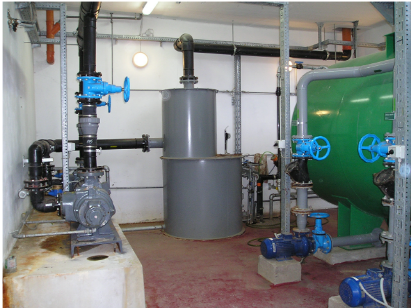
Slika 9. Prikaz hidromašinske opreme u vakumskoj stanici
