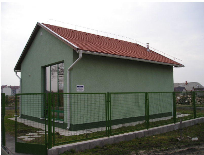
Slika 8. Ukopana vakumska stanica sa nadzemnim delom - Monor
