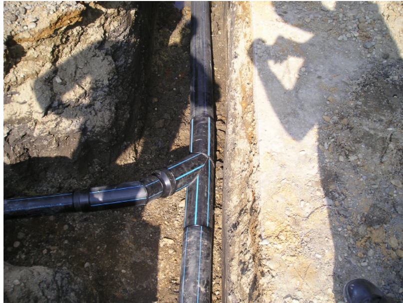
Slika 4. Spajanje toka vakumske glavne mreže u Bačkom Petrovcu
