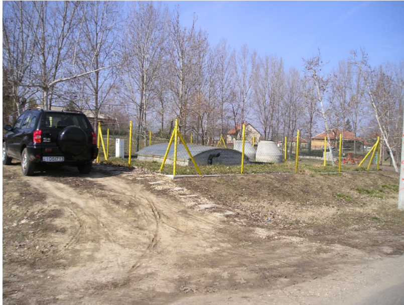
Slika 7. Ukopana vakumska stanica - Tizsakécske
